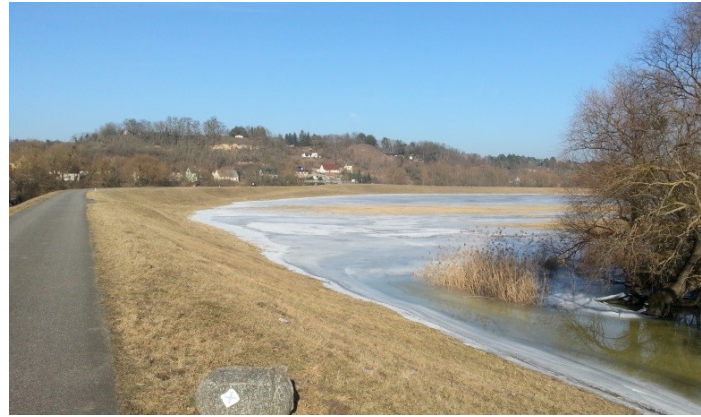
Abb. 5: Deich bei Station 14+300 mit avisierter Lagerfläche im Polder, Blickrichtung Nord (Foto: T. Habermann, W21)
